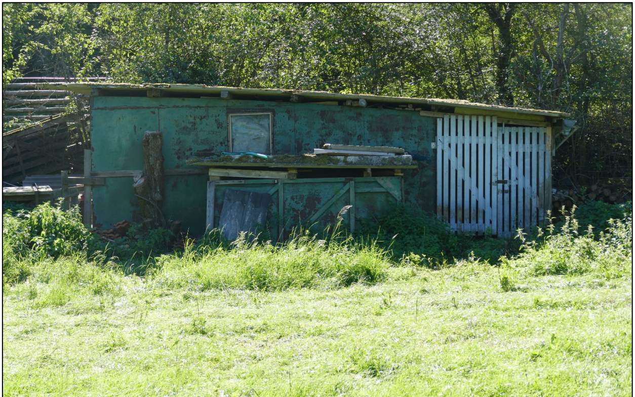
Abb. 5: Vom Eingriff betroffene Hütte am südlichen Rand des Untersuchungsgebiets (IBU, 07.09.2023).
