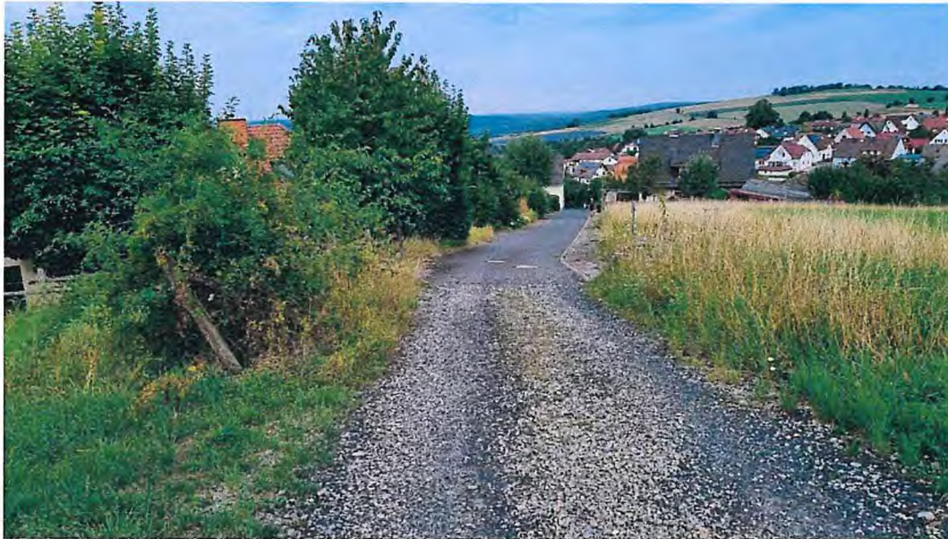
Abbildung 10: Blick auf vorhandene Straße „Am Kiesberg“, 01.08.2024
