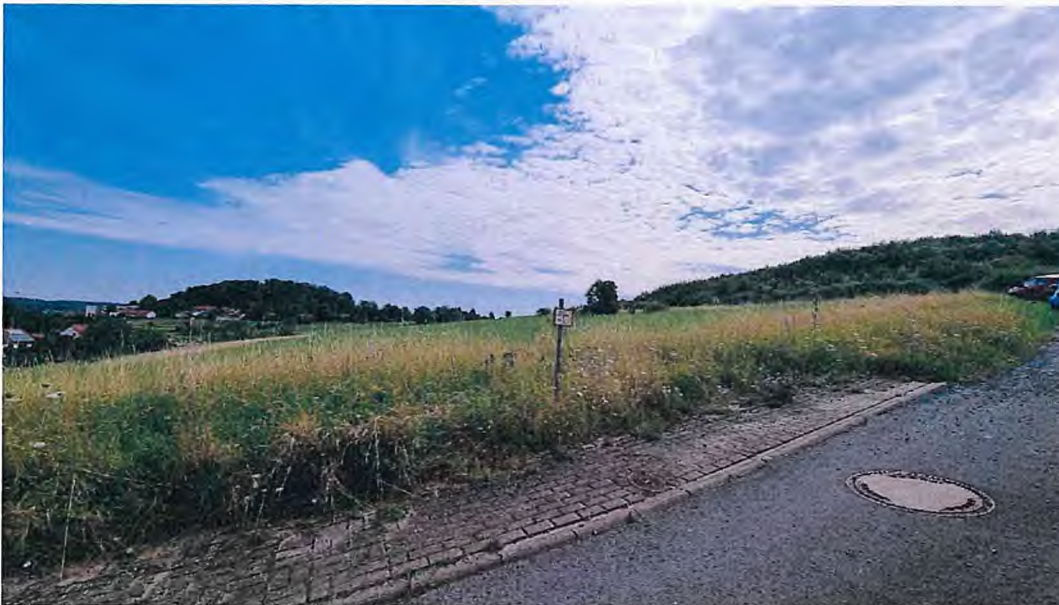
Abbildung 11: Bestehender Straßenausbau mit Kanaldeckel „Am Kiesberg, 01.08.24
